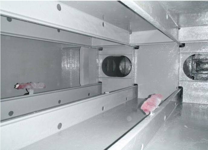
Poor Coating DB. Ballast tank. Raspa edildi, sac ölçüsü alındı, gerekli tamir edilip full boyandı.
