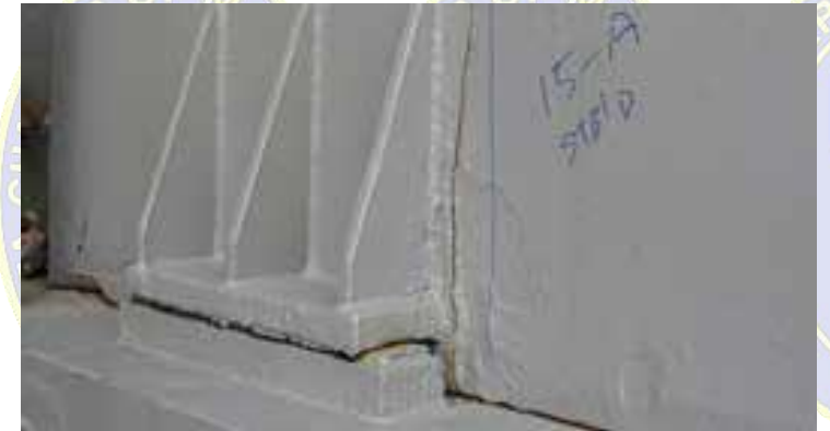
"Bearing pad" 'lerin aşınması sonucu kapak yan sacında «side plate» çatlama
