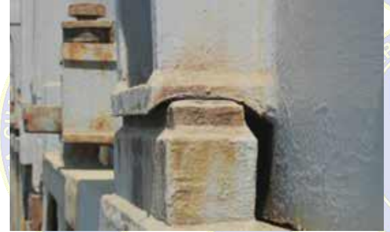
"Bearing pad" 'lerin aşınmış (worn out) yüzeyleri
